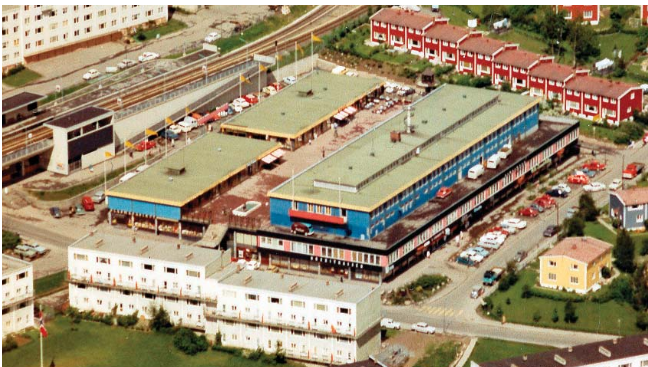
Senteret fotografert i ca. 1960. Senteret hadde ingen overbygning slik det har i dag, og biler kunne parkere på taket.
